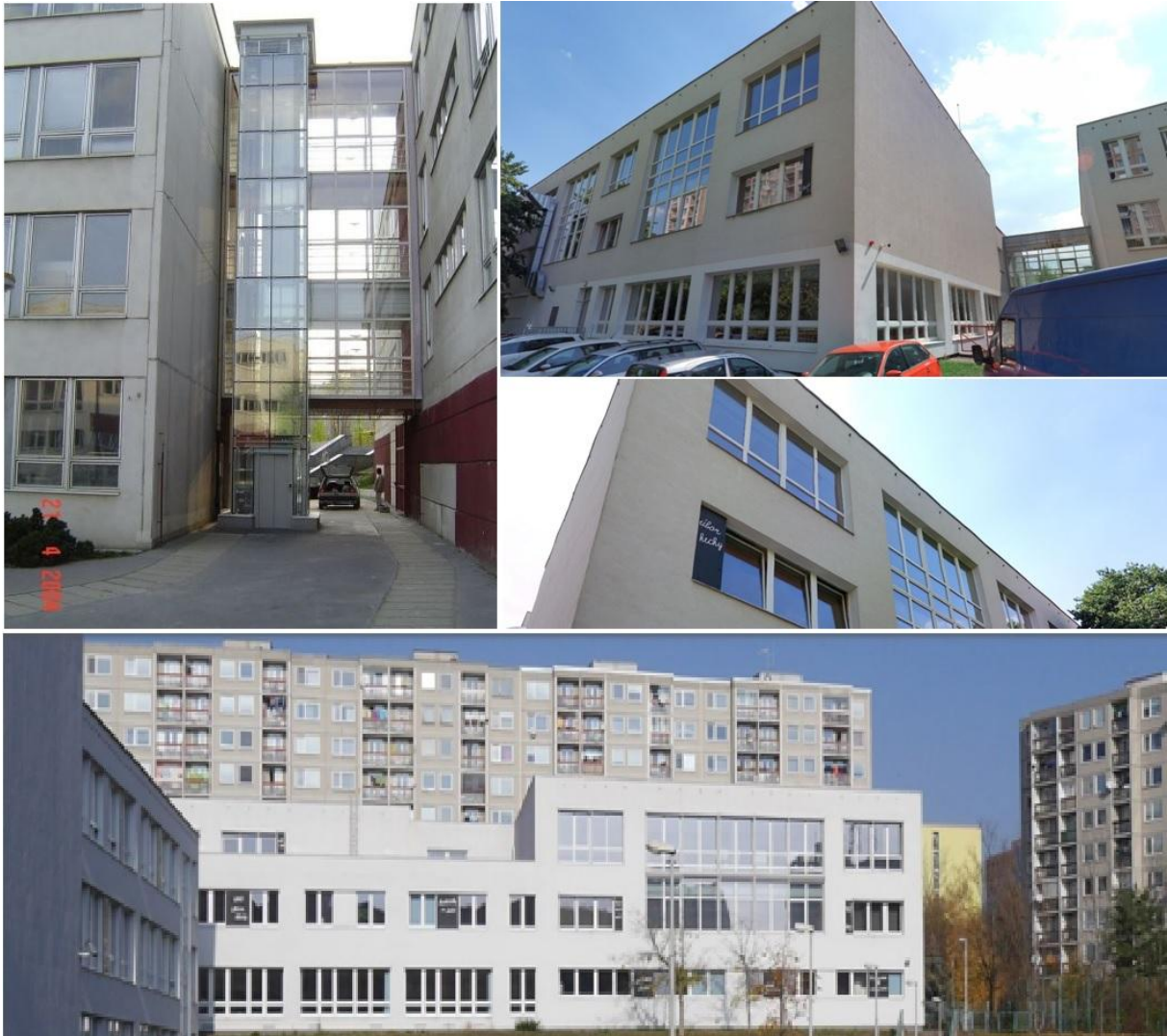
Obr. 2: Největší riziko pro ptáky na ZŠ Vybíralova představují oboustranně prosklené spojovací krčky mezi jednotlivými budovami, skleněné plochy u schodišť a výtahů a reflexivní výplně oken tělocvičny.
